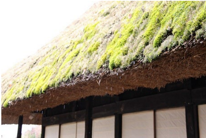
* 飛騨の里のなかの藁葺屋根(部分)
